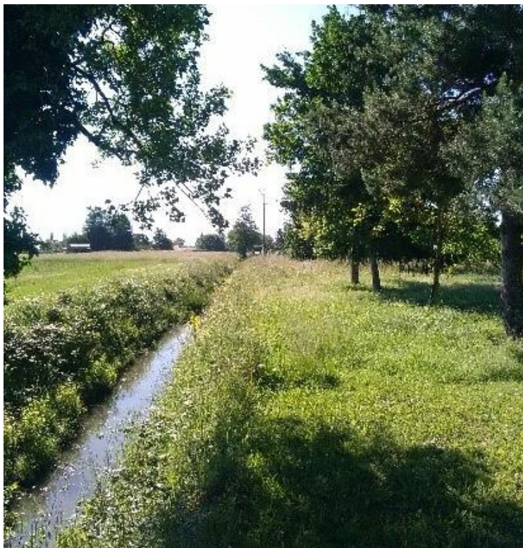
Figure 10 : Photo extérieur 3- Fossé Nord
