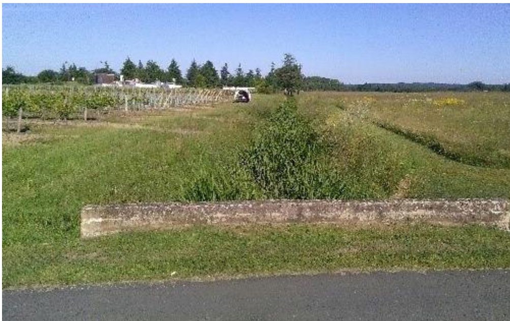
Figure 12 : Photo extérieur 5- Depuis le busage du fossé
